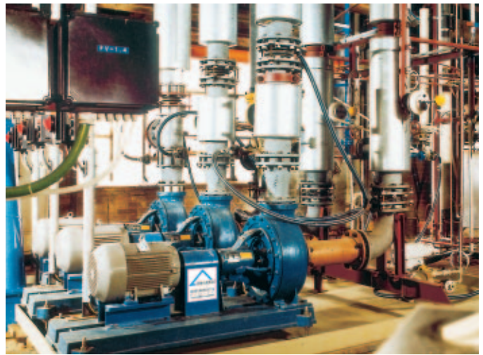
Chemie-Normpumpen Typ RNSi aus Eisen-Siliciumguss in einer Dünnsäure-Eindampf-Anlage.
