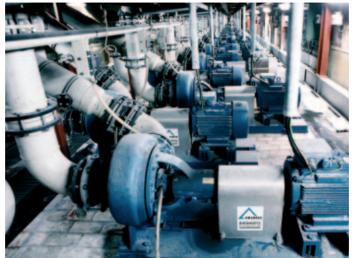
Chemie-Normpumpen Typ RN in der elektrolytischen Verzinkungsanlage eines Kaltwalzwerkes.
